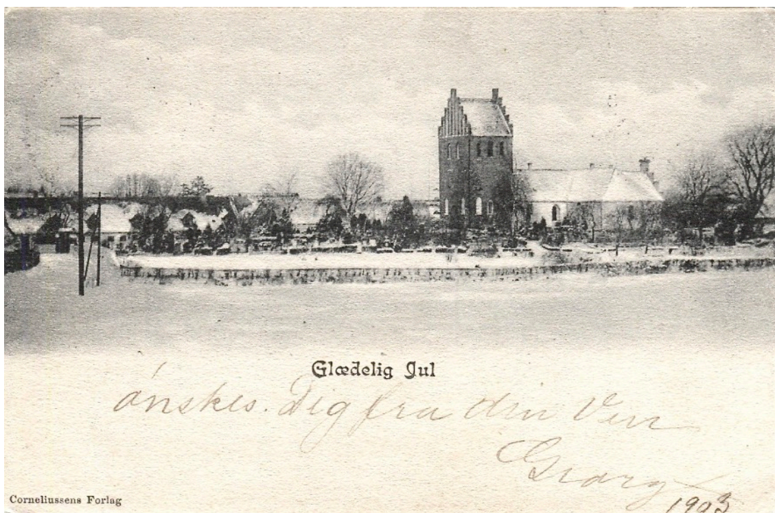
21. Asminderød Kirke ved Hillerød. Der kan være tale om et bestillingsarbejde, da intet tyder på, at Corneliussen har søgt at fremstille kort med alle kirker i Storkøbenhavn eller i øvrigt har interesseret sig for Hillerød-området i det hele taget..
