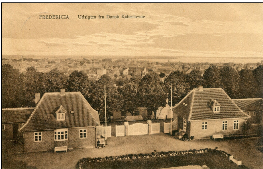
Udsigt fra balkonen mod syd ud over Fredericia, med indgangen og de 2 små administrationsbygninger i forgrunden. Den venstre var portner bolig. Postsendt 9/8 1925. Udgiver: Johs. Brorsens Kunstforlag, København, eneret 156
