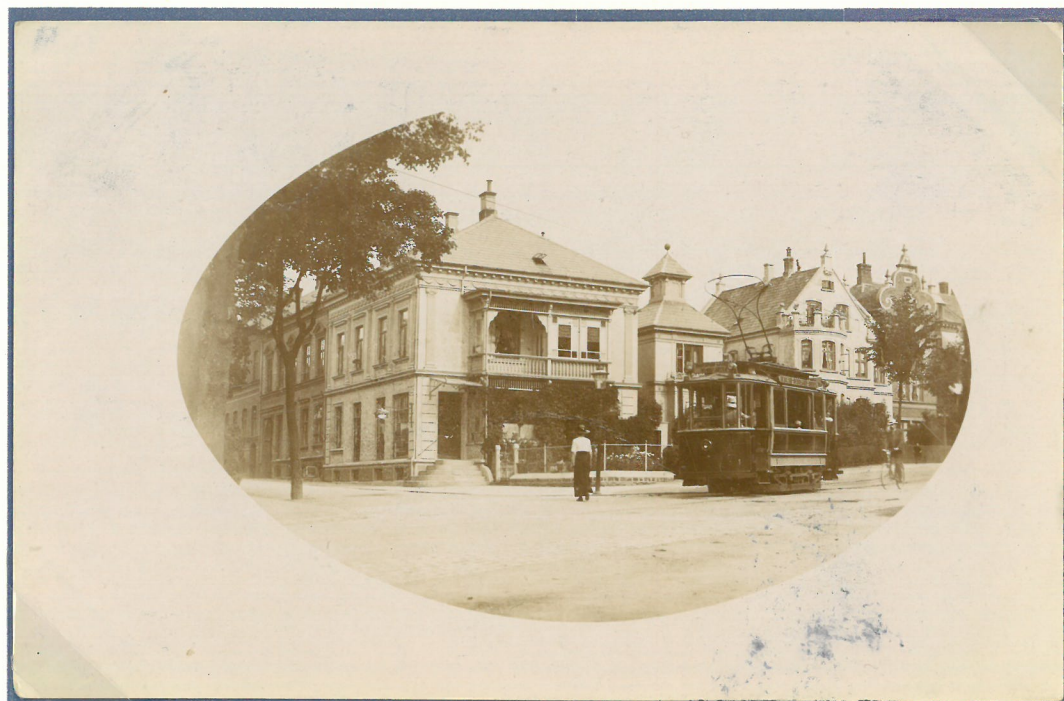
1. Hunderupvej set mod syd ved hjørnet til Allégade tv. Forrest Hunderupvej 24 opført i 1900 og bagved 26 opført i 1897. **
