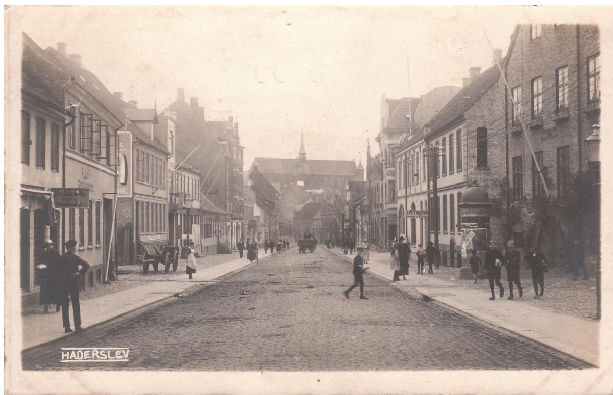
Her søjlen i Nørregade set mod syd med Domkirken, Søjlen stod foran drengeskolen Fridrichschüle som i 1950'erne blev omdannet til by station, bemærk sporet over vej. Ubrugt fotokort fra lige efter Genforeningen 1920.
