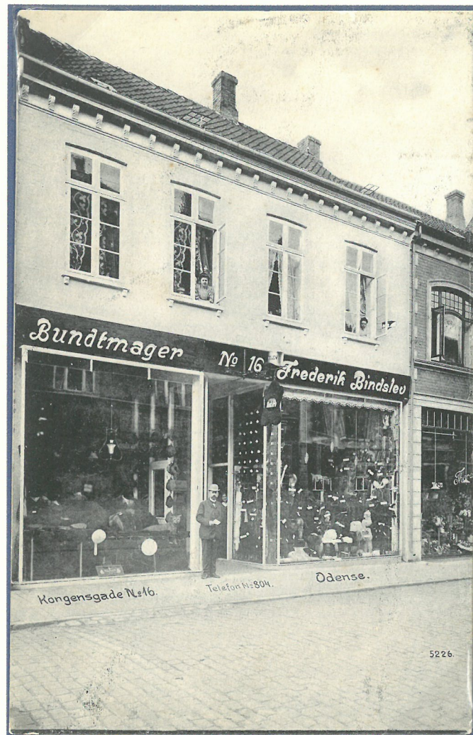
2. Kongensgade 16 er opført i 1851 som beboelse for tre familier. I 1901 blev ejendommen ombygget til butik i stueetage og kælder. Det er antageligt bundtmager Bindslev, som står foran sin butik.
