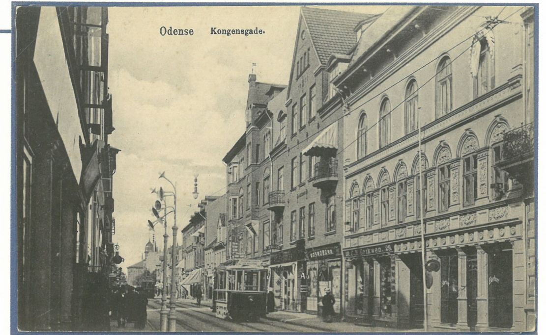
2. Kongensgade set mod nord. Sporvognen er på vej mod Sdr. Boulevard. Th. ligger Kongensgade 29, der blev opført i 1855 og udvidet med yderligere en etage i 1891. I ejendommen er her en frisør og blikkenslager C. M. Eriksen. Læg mærke til alle de lamper der er tv. på kortet. De skal lyse Carl Friis Varehusfacade op. *
