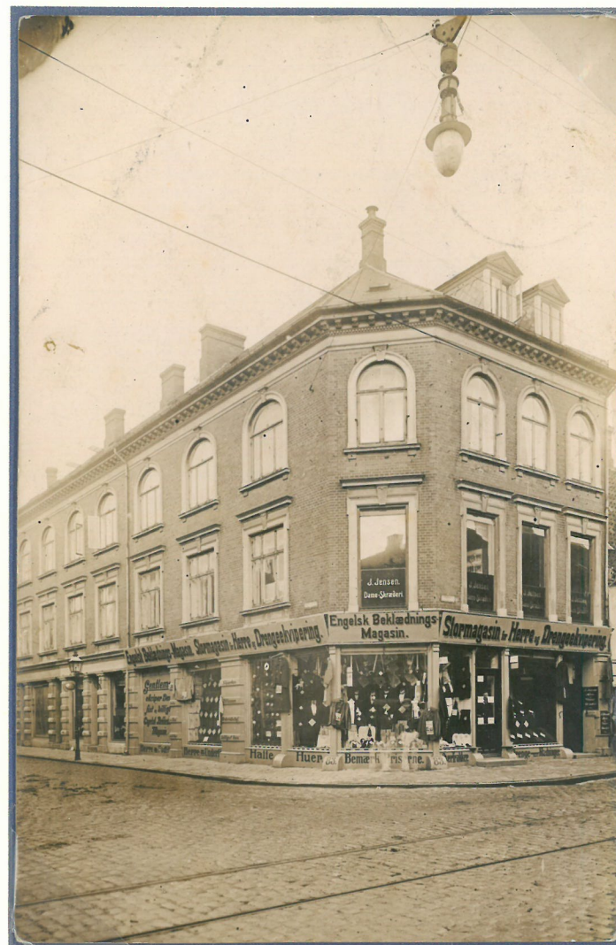
2. Vestergade 83 ligger på hjørnet til Pantheonsgade med Engelsk Beklædningsmagasin og dameskrædder J. Jensen på første sal. Ejendommen blev opført i 1883, men ombygget ved vejgennembruddet til Pantheonsgade i 1897. ***
