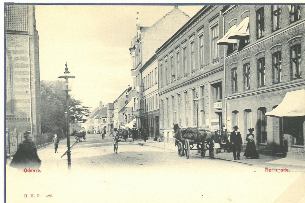
2. Nørregade mod nord foran Skt. Hans Kirke, som fornemmes tv. Hestevognen med øltønder på ladet står foran nr. 45, der siden ca. 1811 var bryggeri. Bygningen er ny-opført fra 1899 efter en omfattende brand. I 1905 blev bryggeriet (Skt. Hans) solgt til Albanibryggerierne, der herefter videreførte bryggeriet under navnet Slotsbryggeriet.
