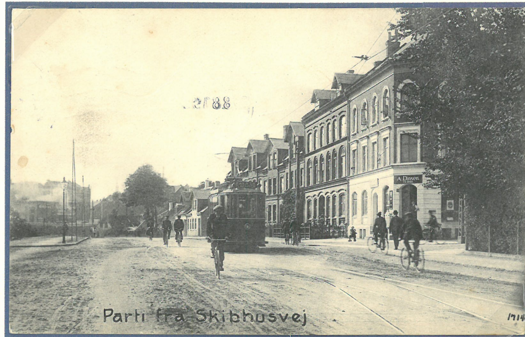
1. Sporvogn ud for Bredstedgade set mod syd. Her kom sporvognen rundt ved de på dette tidspunkt mange nye etageboliger omkring Skibhusvejs sydlige ende. På hjørnet af Bredstedgade ligger købmand A. Dinsen, Skibhusvej 34. *
