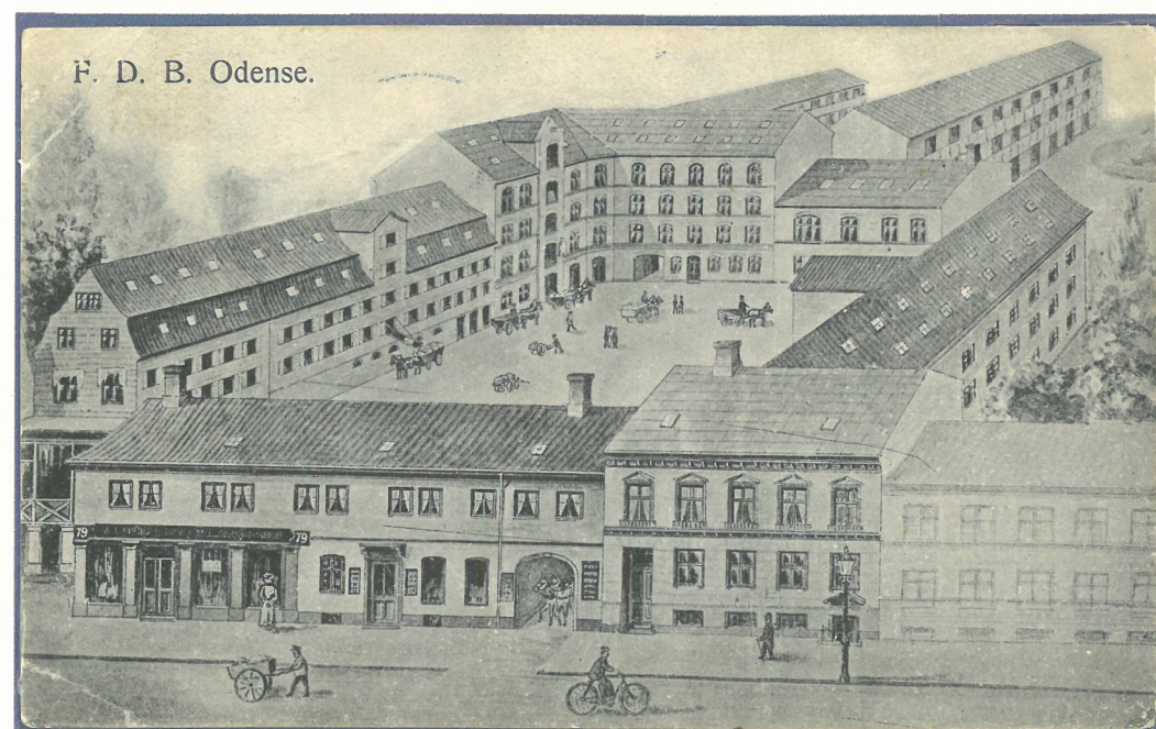
1. F.D.B. (Forenede danske Brugsforeninger) havde et større bygningskompleks med kontorer og lagerbygninger på adressen Nørregade 77-79. Bygningerne tv. blev revet ned i 1914-15 i forbindelse med vejgennembrud af Østre Stationsvej mod øst. **
